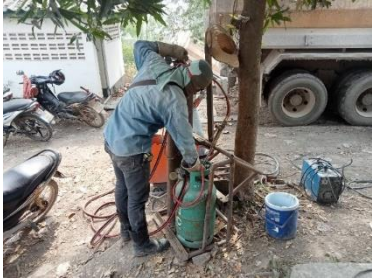
การปฏิบัติงานเกี่ยวกับการตัดเหล็กพนักงานได้สวมใส่อุปกรณ์ป้องกันตามมาตรฐาน
