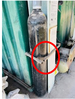
เหล็กยึดโยงถังออกซิเจนที่ใช้งานในอาคารเตรียมได้อย่าง ได้ชำรุดแต่ได้ทำการซ่อมแซมเรียบร้อยแล้ว
