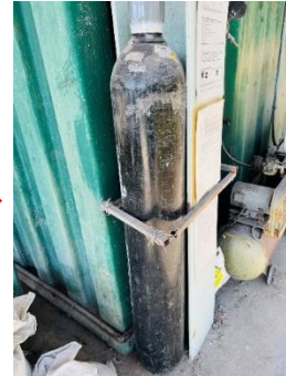
เหล็กยึดโยงถังออกซิเจนที่ใช้งานในอาคารเตรียมได้อย่าง ได้ชำรุดแต่ได้ทำการซ่อมแซมเรียบร้อยแล้ว
