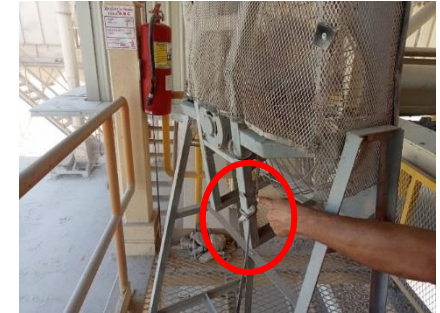
สายไฟของพัดลมได้ชำรุดอาจเกิดอันตรายจึงได้สั่งให้หยุด ใช้งานและทำการแก้ไขก่อนที่จะกลับไปใช้งาน
