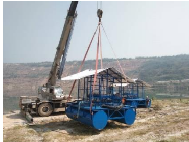
งานยกเพื่อติดตั้งปั๊มน้ำโซล่าเซลล์ ก่อนปฏิบัติงานได้มีการวางแผนและแบ่งหน้าที่เพื่อให้งานมีความปลอดภัยสูงสุด
